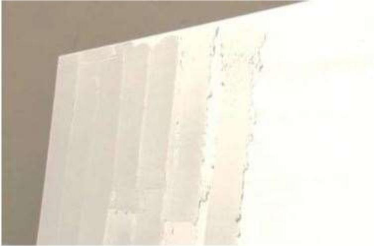
4. Posizionare la lastra sul letto di colla facendo attenzione a mantenere una fuga minima di 2mm.
