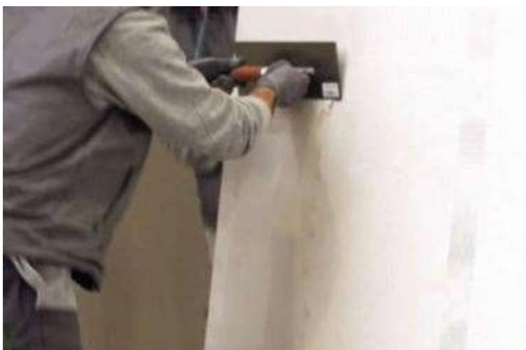
3. Successivamente stendere il collante sul sottofondo mediante spatola con denti da 6x6 mm. **L'adesivo sul sottofondo deve essere steso seguendo lo stesso verso di stesura dell'adesivo sul retro della lastra.** Vanno evitati gli incroci di adesivo che potrebbero intrappolare micro-bolle d'aria.
